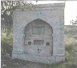
Çoban Çeşmesi ve Köprüsü - Yenibosna / İstanbul
