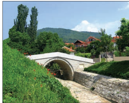
İvranye'de tek kemerli Osmanlı köprüsü ve kitâbesi
